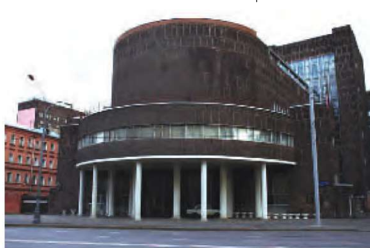
Здание Госкомстата. Архитектор Ле Корбюзье. 1928–1937 гг.
