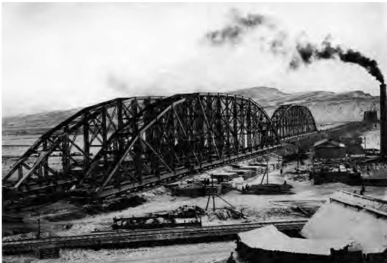
Строительство моста через р. Енисей. Фото 1899 г.
